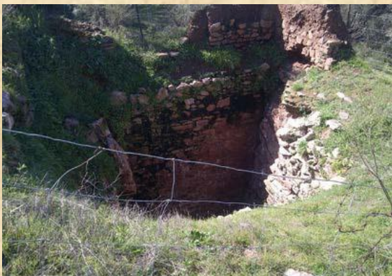
Foto: vista del pozo auxiliar de la Ligera. Foto: N. Gaspar.
