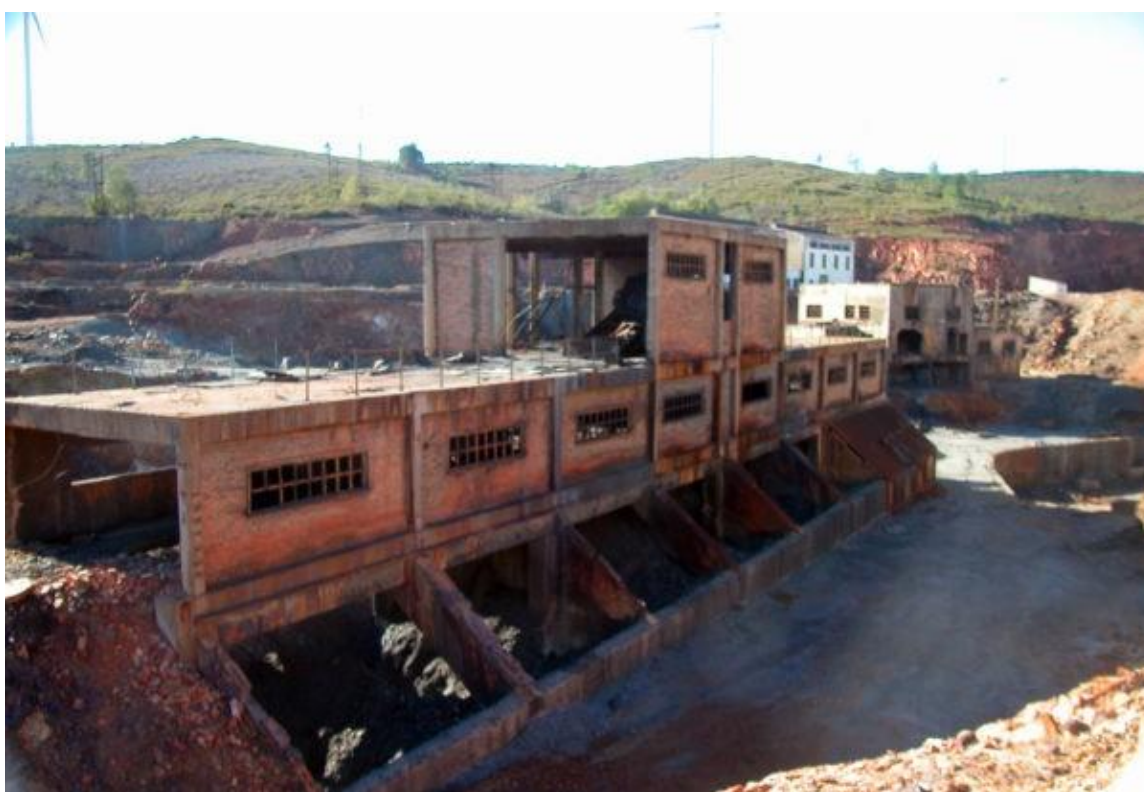
Restos de instalaciones en Filón Norte
