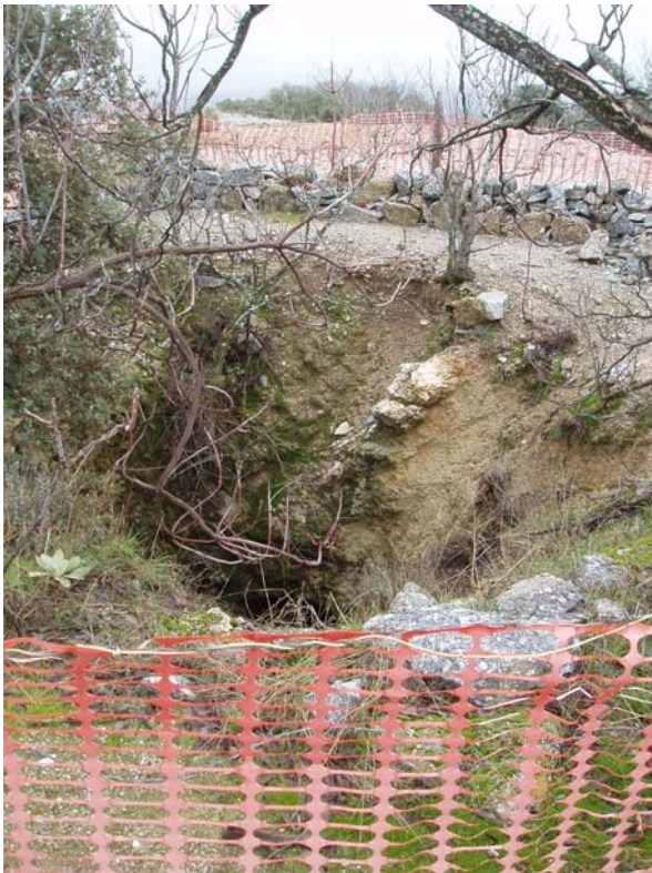
6. Pozo secundario, con pequeño brocal y vallado de malla plástica.
