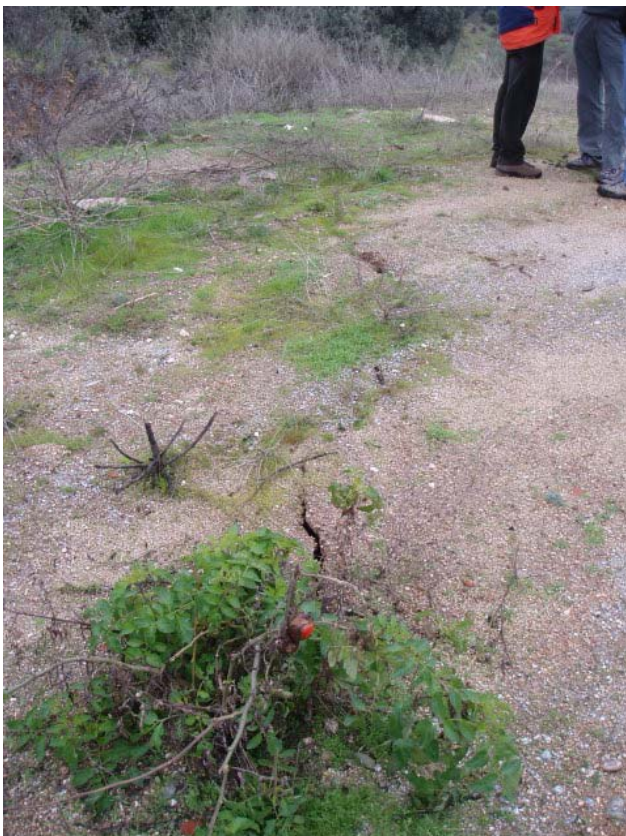
4. Grieta sobre el terreno de relleno.
