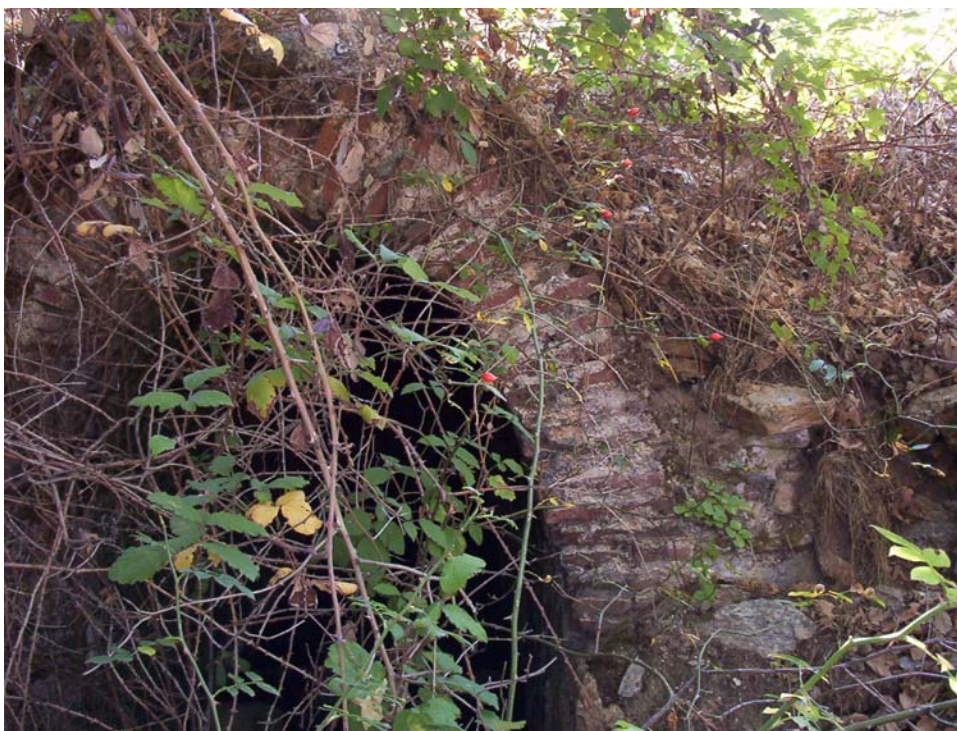
1. Bocamina, revestida de ladrillo.
