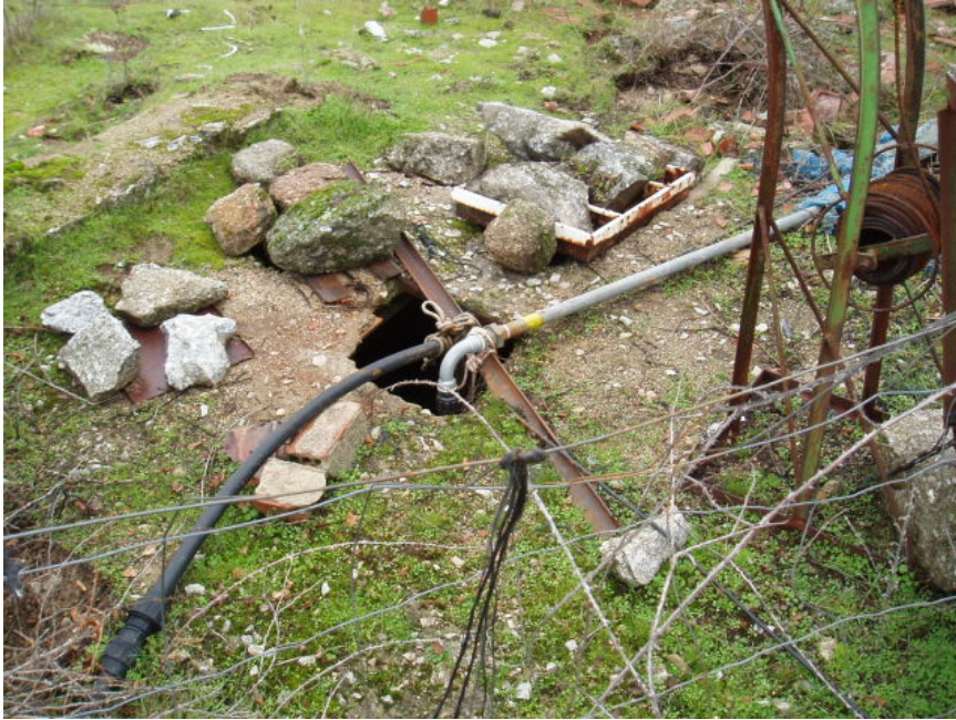
3. El pozo, tapado, con toma de agua.
