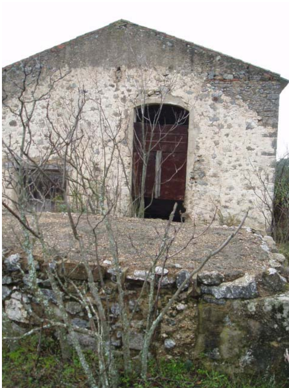
3. Edificio de máquinas, y pozo maestro tapado en primer plano.
