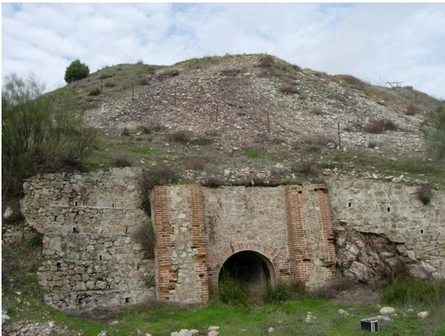
2. Bocamina, y escombreras en la parte superior.
