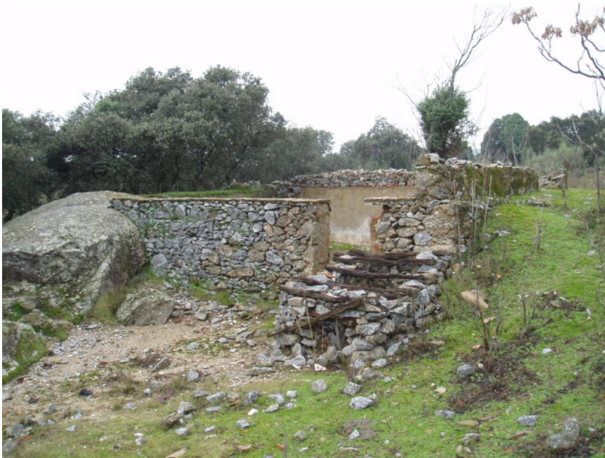
5. Otra vista de restos de las labores.
