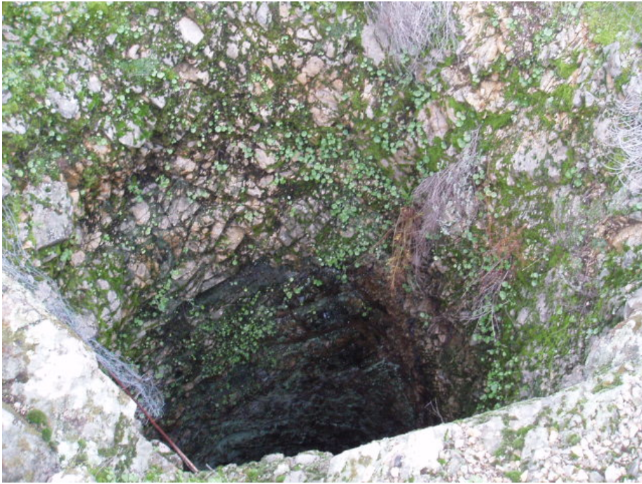
3. Emboquille del pozo.
