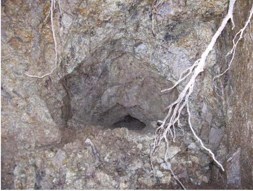
2. Bocamina prácticamente hundida.
