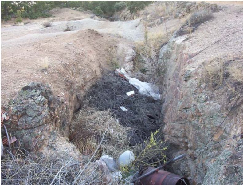
1. Calicata rellena de escombros.
