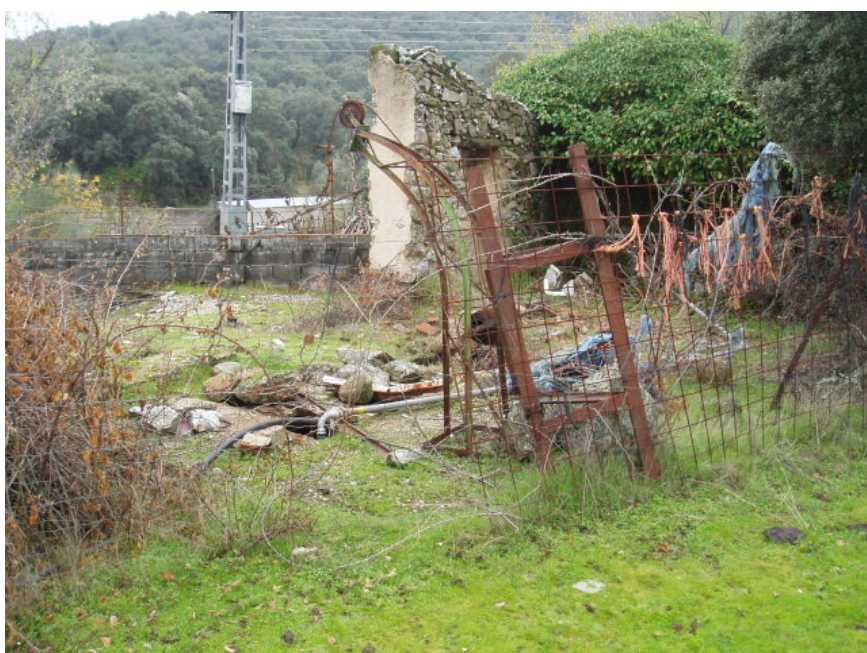
2. Aspecto del emboquille del pozo.
