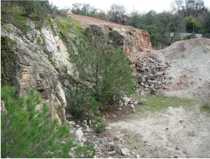
3. Taludes y escombreras.
