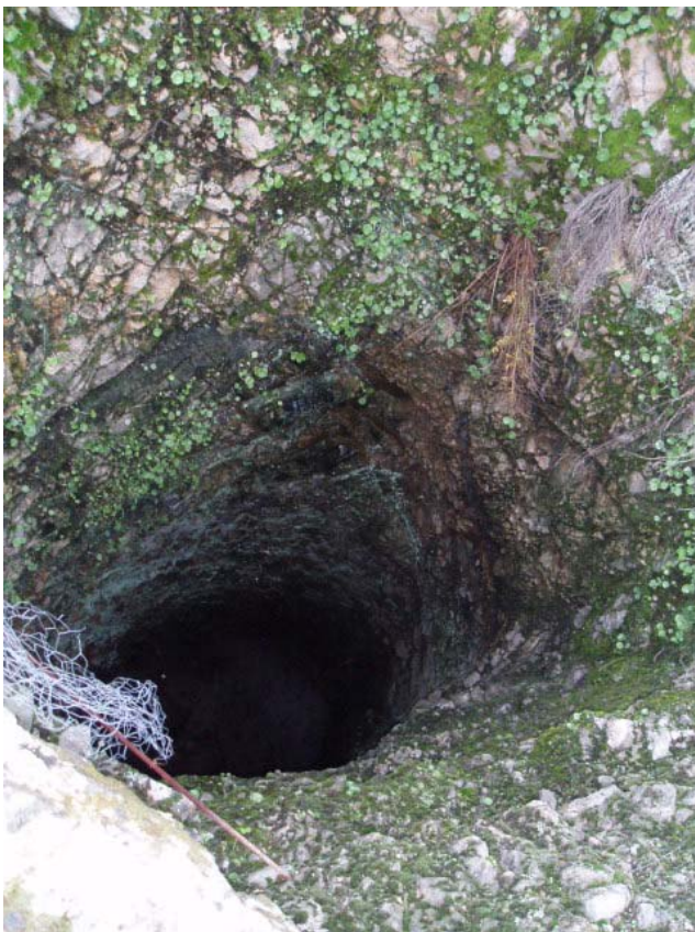
4. Otra vista del pozo donde se aprecia la profundidad.
