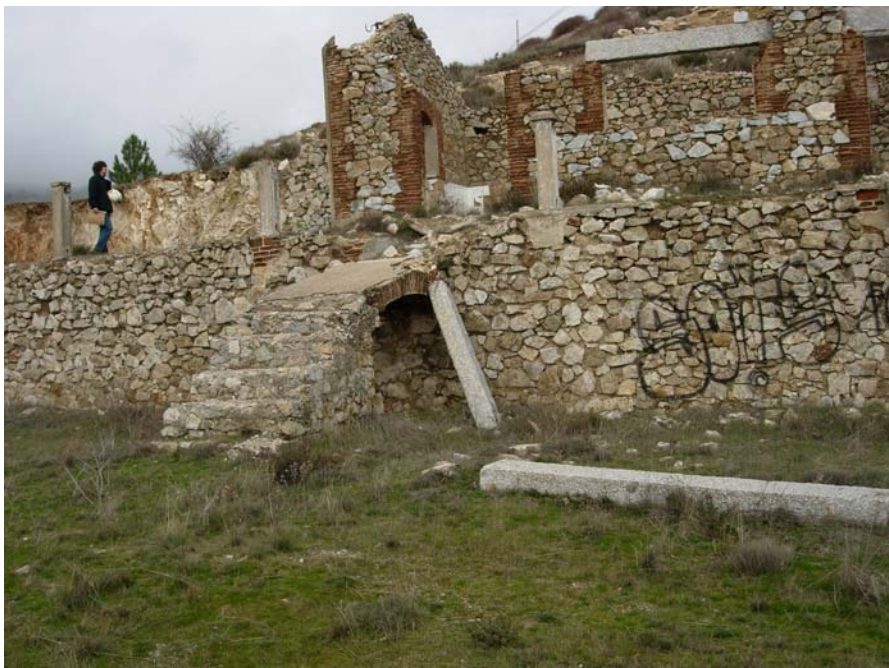
4. Ruinas de las edificaciones.
