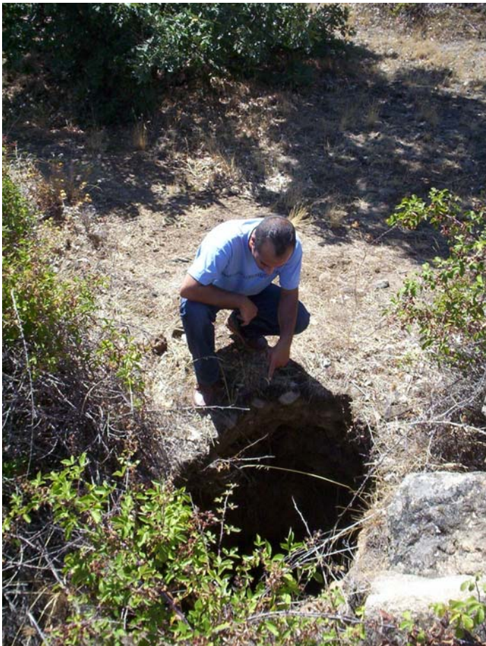
2. Aparición en 2004 de un hundimiento a favor de un conducto de ventilación desconocido y relleno parcialmente de escombros.
