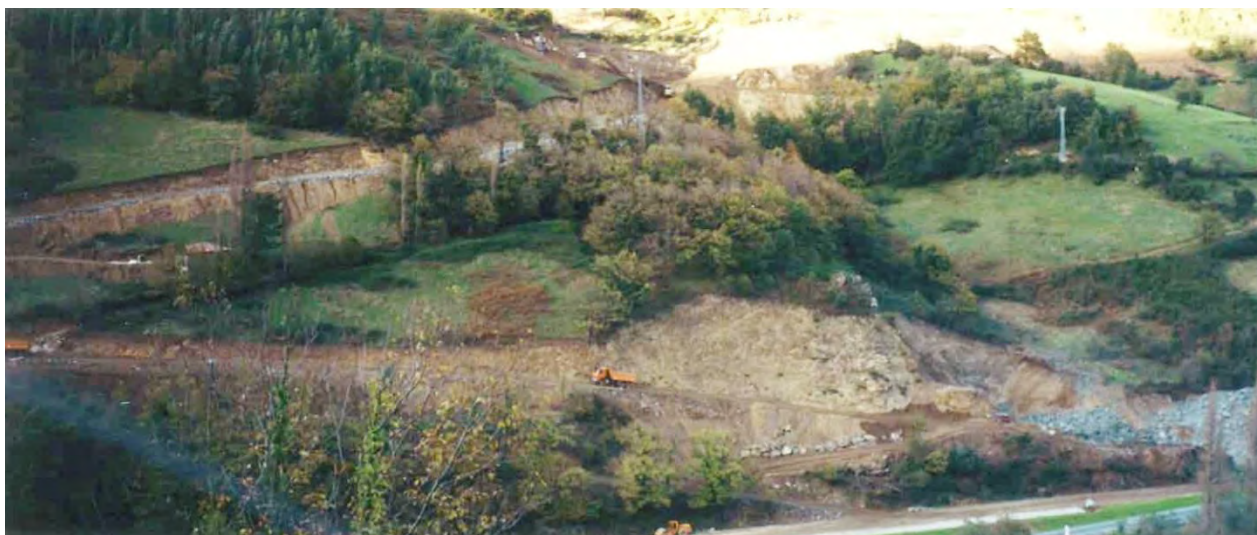
Fig. 21. Año 2000. Pista de transporte finalizada. (Fuente RNGMSA) A la izquierda se observa la pequeña explotación de Carlés Este.
