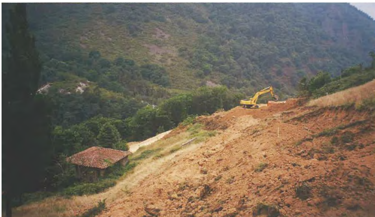
Fig. 18. Año 1999. Construcción de accesos. (Fuente RNGMSA)
