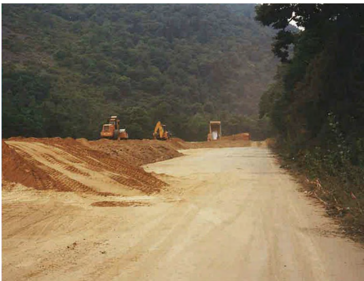
Fig. 16. Año 1999. Construcción de las balsas de decantación de aguas de tormenta. (Fuente RNGMSA)
