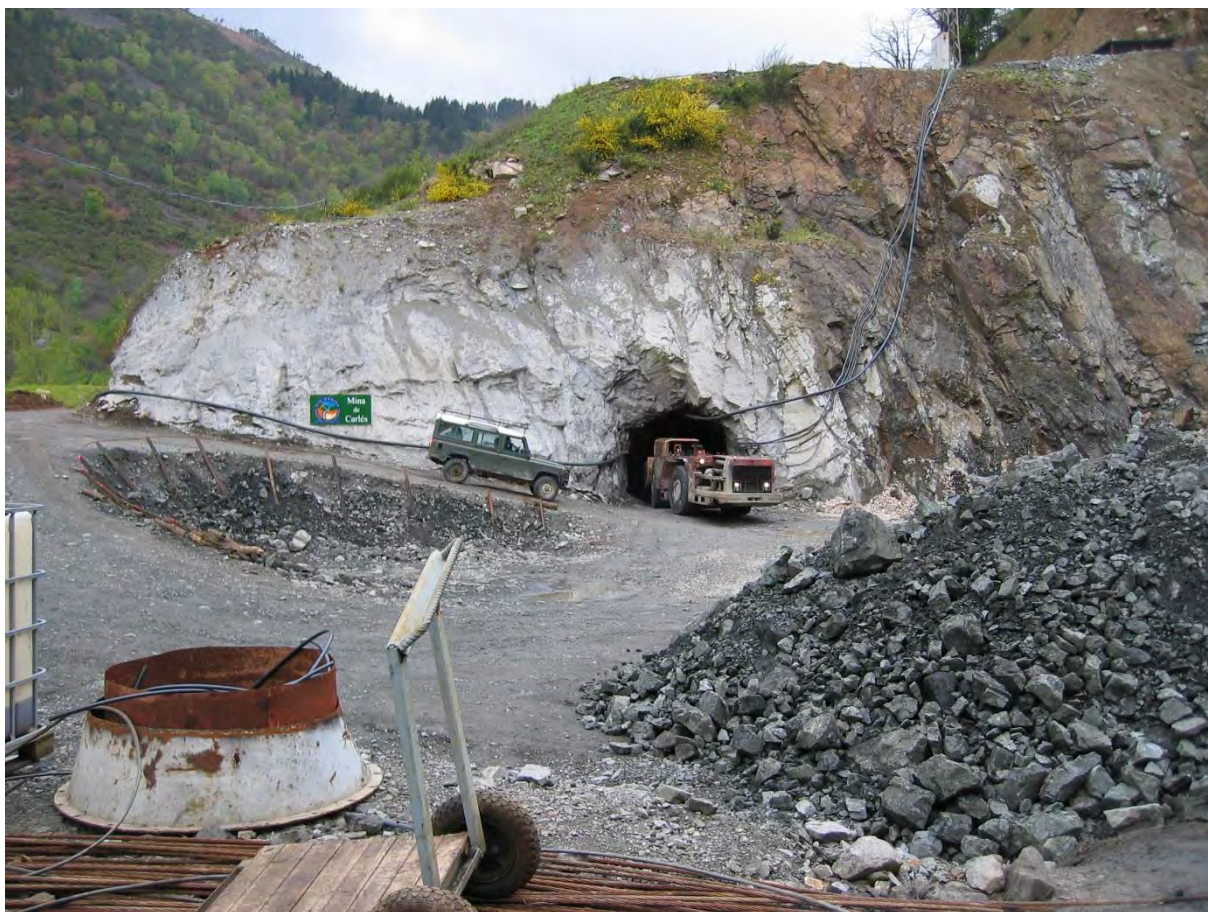
Fig. 38. Acopio de mineral procedente del subterráneo de Carlés Este. Año 2004. (Foto: Agustín Sanz)
