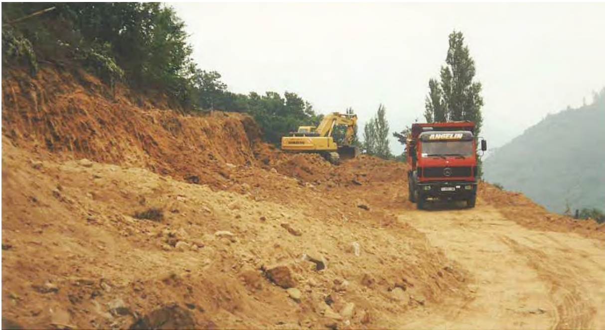
Fig. 19. Año 1999. Construcción de accesos a la explotación de Carlés Norte. (Fuente RNGMSA)
