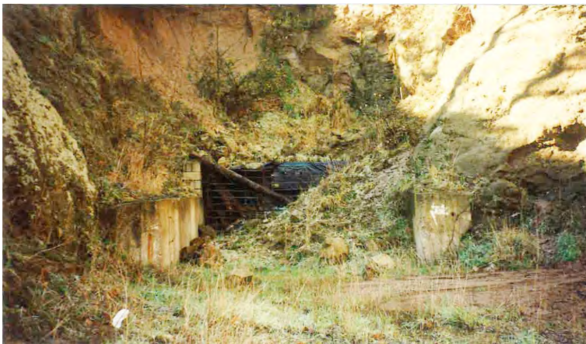
Fig. 31. Antigua galería de investigación realizada por Anglo American Corporation (Fuente RNGMSA)
