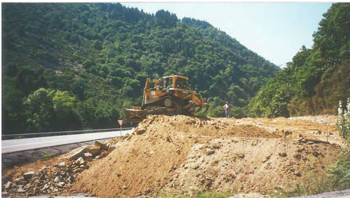
Fig. 15. Año 1999. Construcción de las balsas de decantación de aguas de tormenta. (Fuente RNGMSA)
