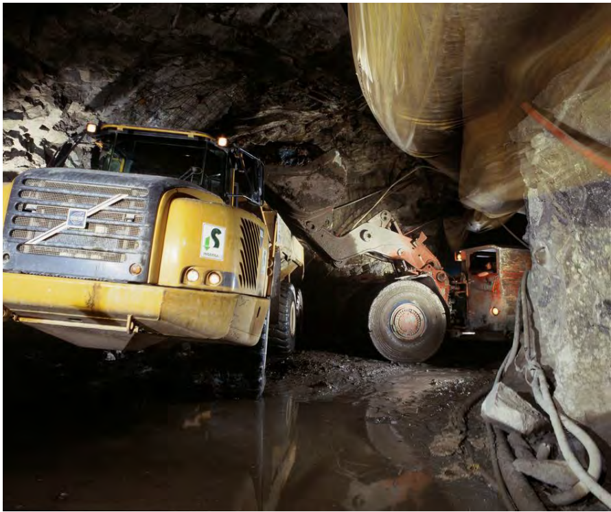
Fig. 37. Carga de pala sobre camión para su transporte al exterior. (Fuente RNGMSA).
