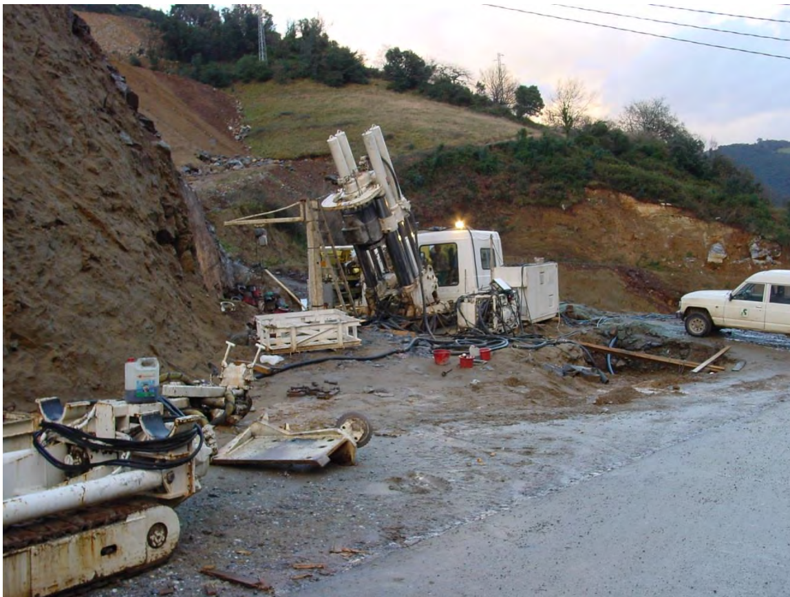
Fig. 32. Ejecución de una chimenea de ventilación con Raise Boring. Año 2003. (Fuente RNGMSA)
