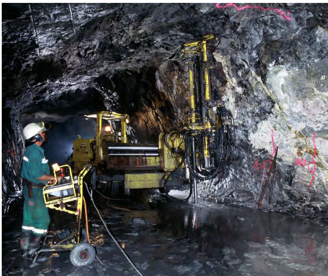
Fig. 44. Perforación de barrenos de producción con Simba (Fuente RNGMSA)
