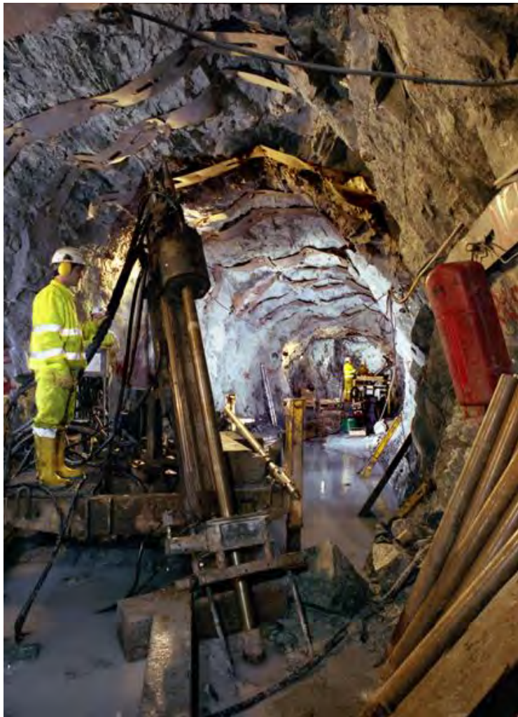
Fig. 34 Drenada y recuperada la galería, se ejecutan sondeos de definición de las zonas mineralizadas en el interior de la galería de Carlés (Fuente RNGMSA).
