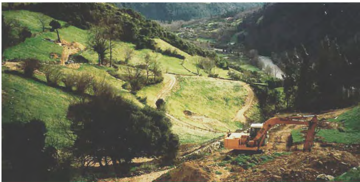
Fig. 23. Año 2000. Retirada de tierra vegetal en Carlés Norte. (Fuente RNGMSA)
