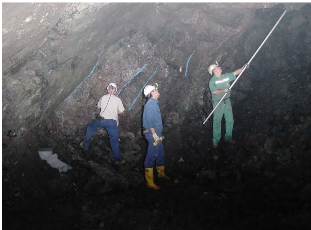
Fig. 43. Saneo manual de techos. (Fuente RNGMSA).
