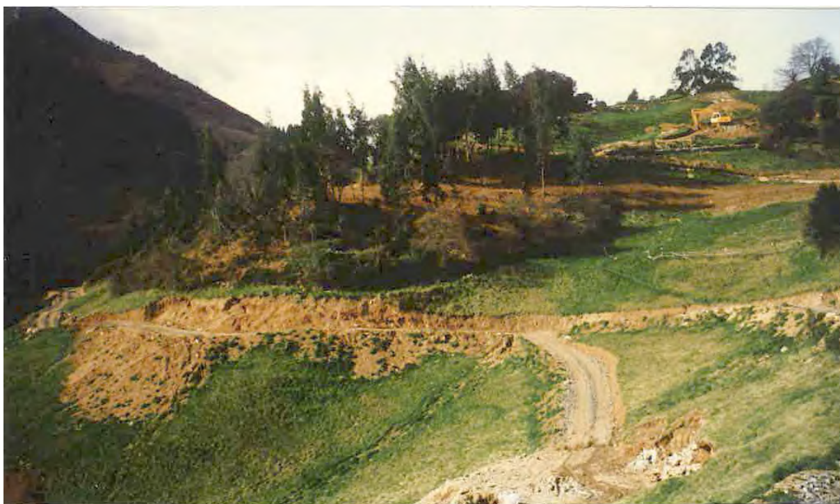
Fig. 22. Año 2000. Realización de accesos a diferentes niveles de la explotación Carlés Norte. (Fuente RNGMSA)
