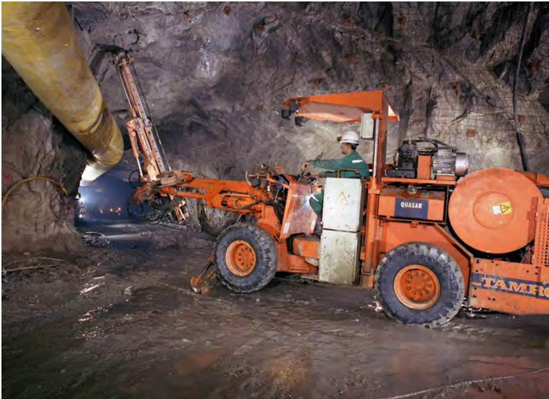
Fig. 42. Perforación de pernos con jumbo. Las buenas características autoportantes de la roca de caja se confirmaron durante las labores de explotación, siendo necesario el sostenimiento puntual de algunas zonas. (Fuente RNGMSA).
